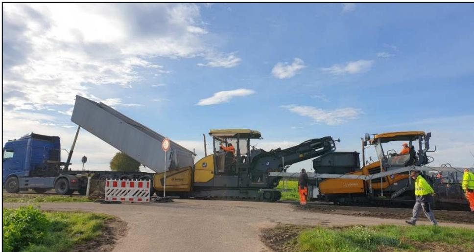
**Abbildung 4-101: Einbau der temperaturabgesenkten Asphaltbinderschicht**
