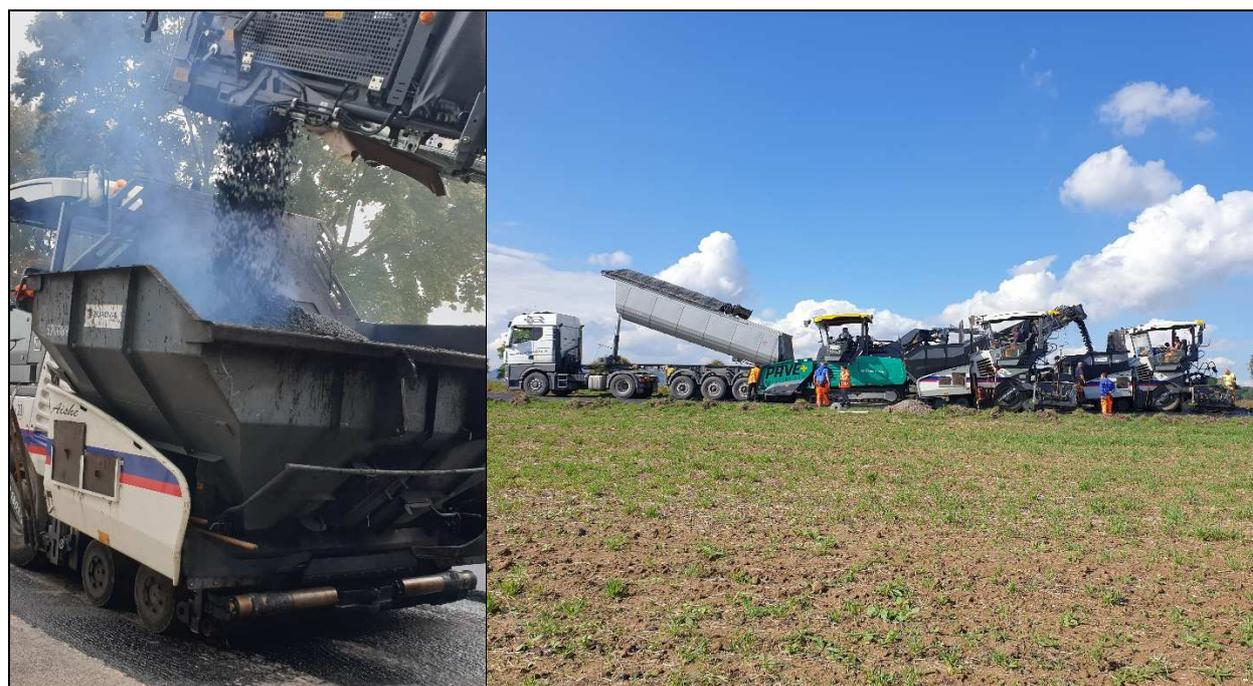
**Abbildung 4-84:** Dampfentwicklung beim Einbau des Referenzfeldes (links), Dampfentwicklung beim Einbau des NTA-Feldes (rechts)
