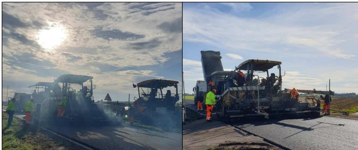
**Abbildung 4-102: Dampfentwicklung beim Einbau des konventionellen Mischgutes (links) und temperaturabgesenkten Mischgutes (rechts)**
