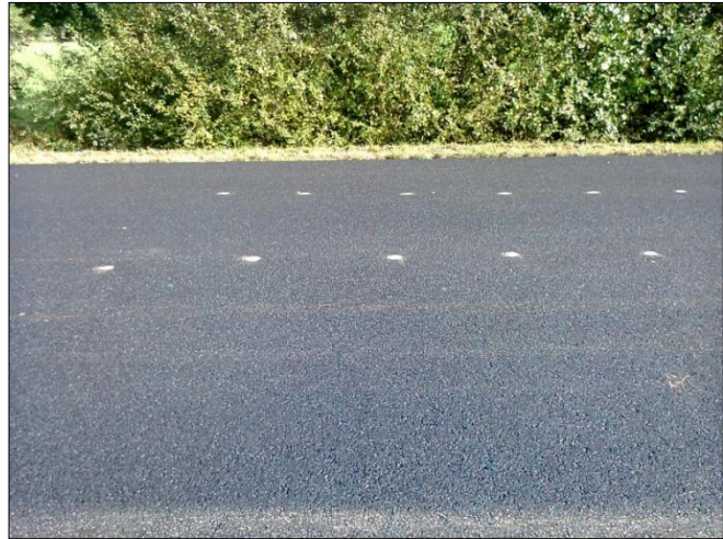
Abb. 13: Meßpunkte im Prüffeld 4 zur Kontrolle der Verdichtung des Asphaltbinders AC 16 B S, 25/55-55 A auf der Baustelle 3
