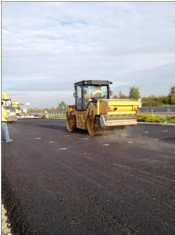
Abb. 11: Walzbahnen 2 bis 7 mit 18 Einzelmeßstellen im Prüffeld 2 der Baustelle 1
